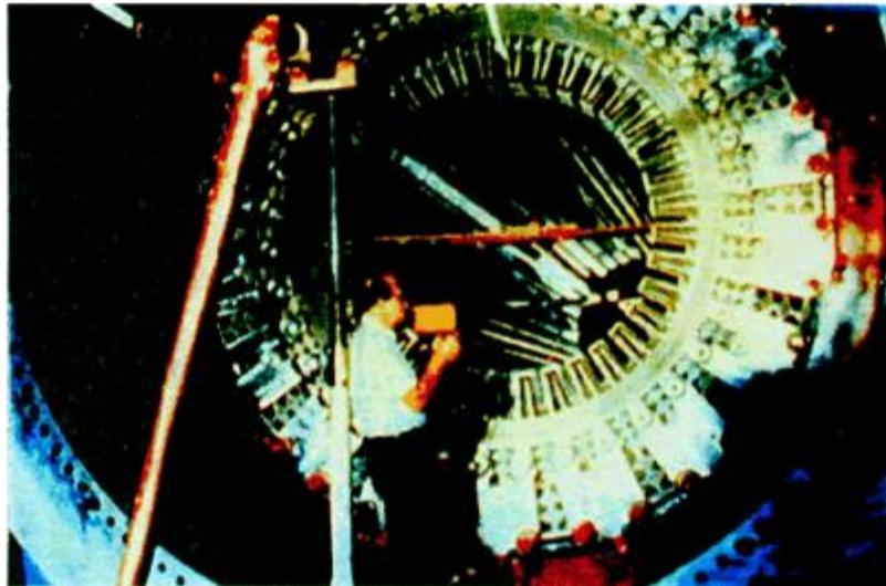
Ввиду небольшой мощности генератора контроль осуществляется без применения специальных устройств, путем просмотра тепловизором поверхности стали статора со стороны возбудителя и со стороны турбины.
